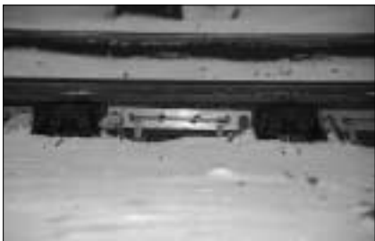
Figuur 14.2 Spoorwegwisselverwarming
